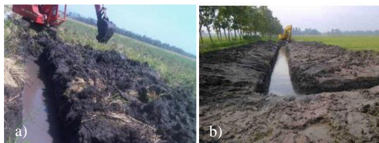
Gambar 9. Pembuatan Saluran Drainase
