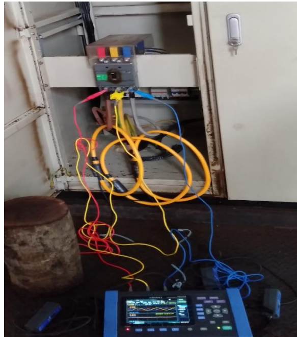
Gambar 15 Pemasangan Alat Pengukuran Power Analyzer
