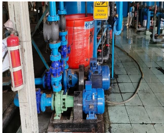
Motoran pada stasiun Demint plant
