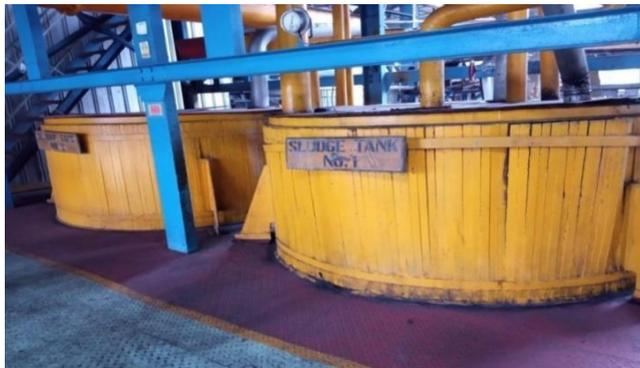
**Gambar 23. Sludge Tank**
