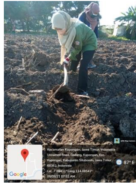
Gambar 3. Pembuatan Got Malang Sumber : Dokumentasi Sendiri
