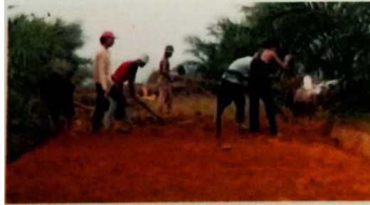
Gambar 52. Persiapan jalan koleksi
