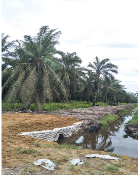
Gambar 7. Hasil pembuatan parit isolasi
