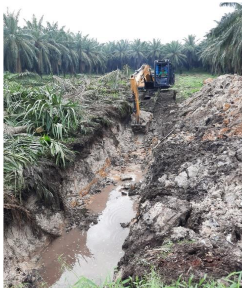
Gambar 6. Kegiatan pembuatan parit isolasi dengan alat berat Excavator
