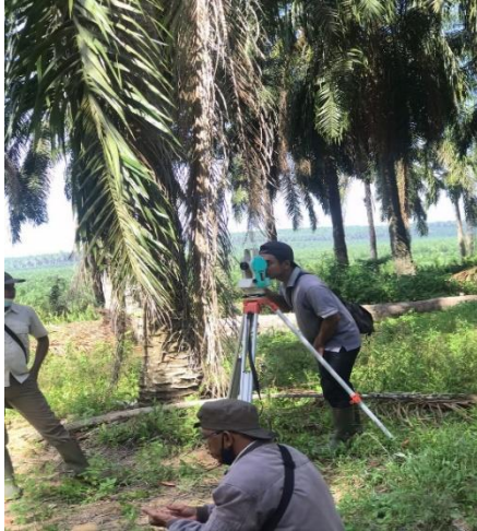
Gambar 5. Kegiatan pemancangan menggunakan alat deodolit
