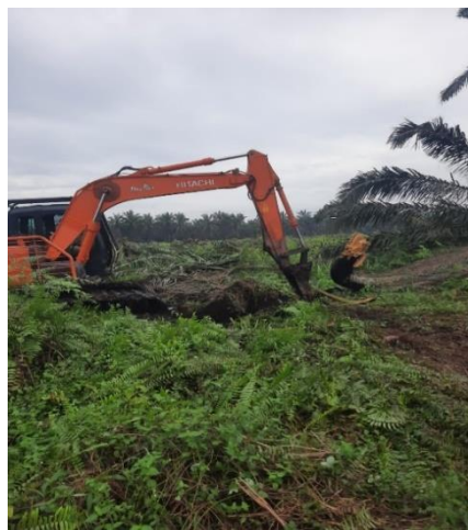
Gambar 8. Kegiatan penumbangan pohon kelapa sawit dengan alat Excavator
