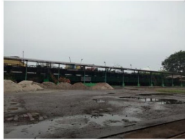
Gambar 2. 45 Stasiun Loading Ramp
