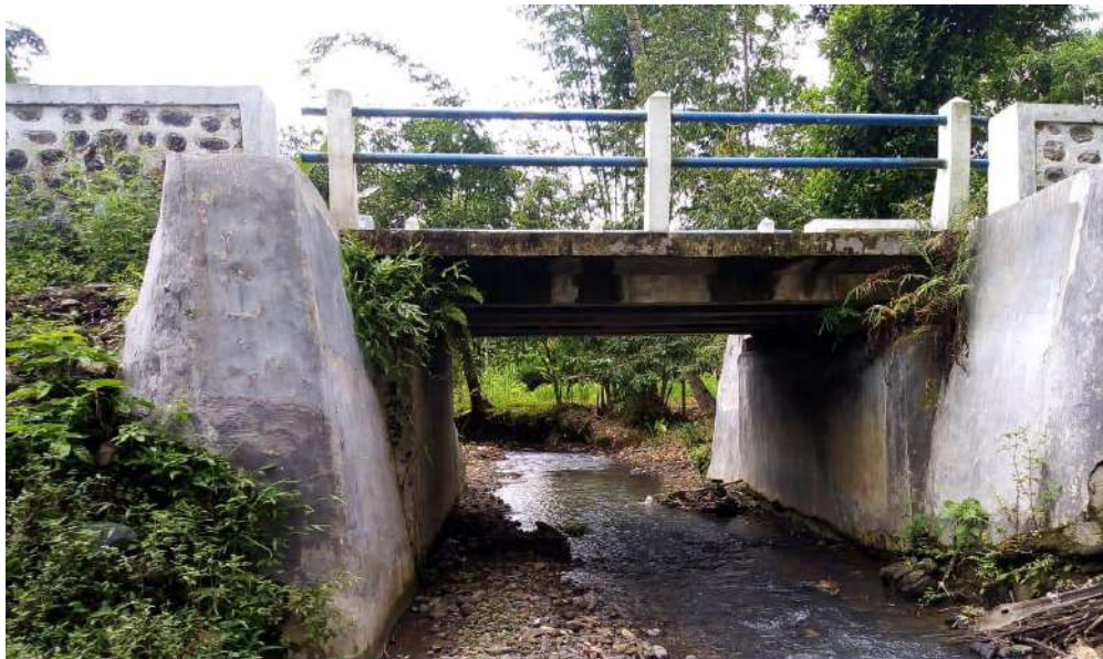
Gambar 25. Jembatan Beton, Lokasi Afd. Kp.Anyar Kebun Kendenglembu
