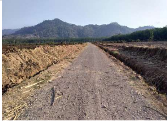
Kondisi Jalan Yang Dilakukan Penimbunan, Lokasi Kebun Kalisanen
