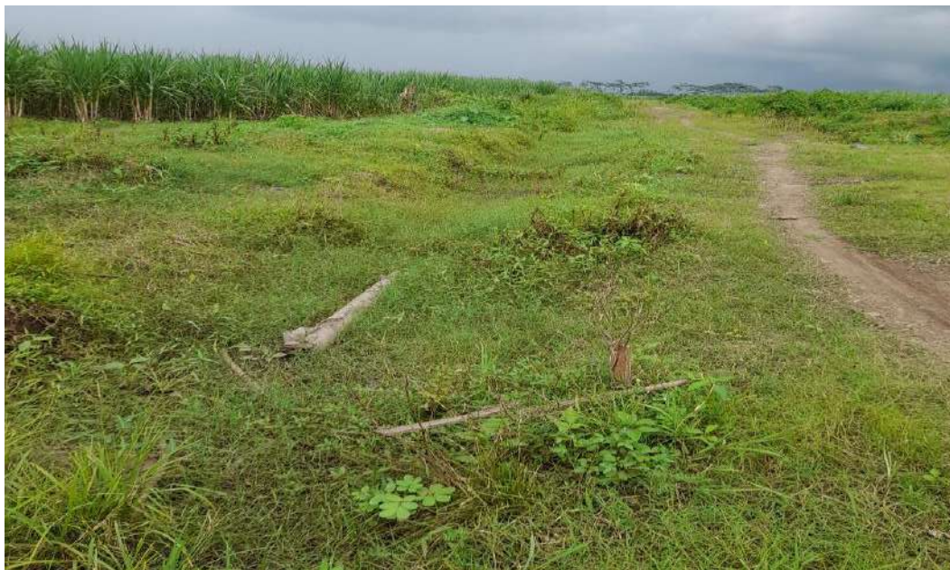
Gambar 40. Kondisi Saluran Air Yang Perlu Dilakukan Perawatan, Kebun Mumbul
