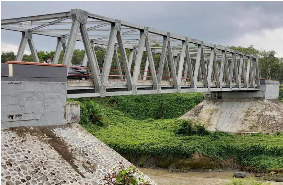
Gambar 27. Jembatan Dengan Kontruksi Baja (Steel Bridge), Lokasi Kebun Kalirejo
