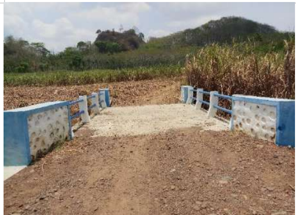
Kondisi jembatan yang digunakan untuk menghubungkan petak kebun
