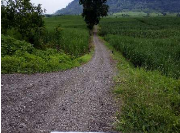
Kondisi Jalan Yang Dilakukan Penimbunan, Lokasi Kebun Kendenglembu
