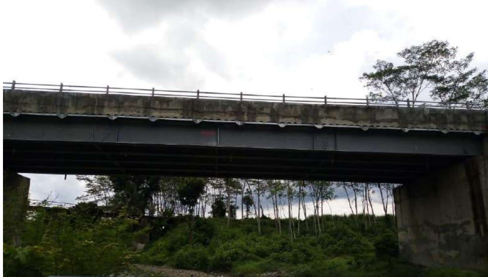
Gambar 26. Jembatan Dengan Kontruksi Cor Beton Begisting, Lokasi Afd. Rejosari Kebun Kendenglembu
