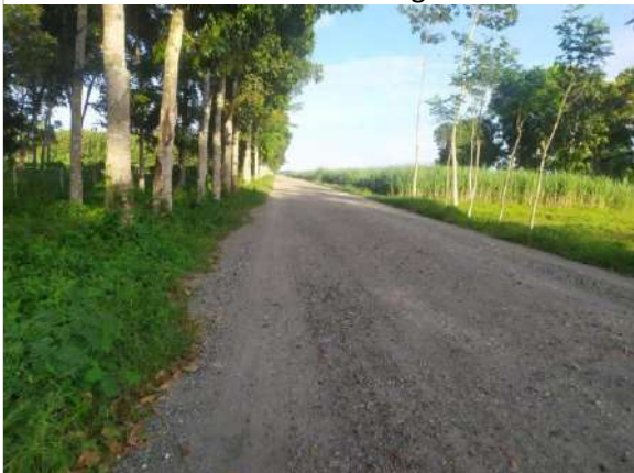
Kondisi Jalan Yang Dilakukan Penimbunan, Lokasi Kebun Kalirejo
