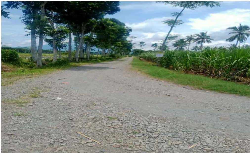
Gambar 22. Materila Timbunan Jalan Yang Sudah Standar, Lokasi Kebun Kalikempit
