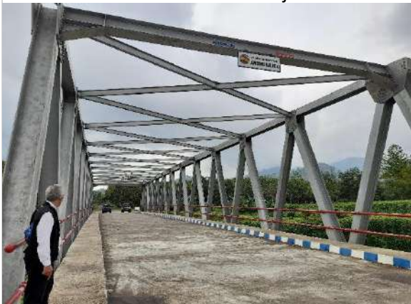
Jembatan Kebun Kalirejo yang telah selesai pengerjaannya
