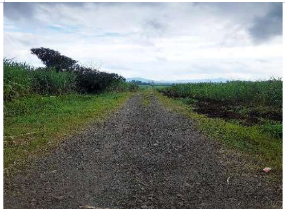
Kondisi jalan yang dilakukan penimbunan di Kebun Mumbul
