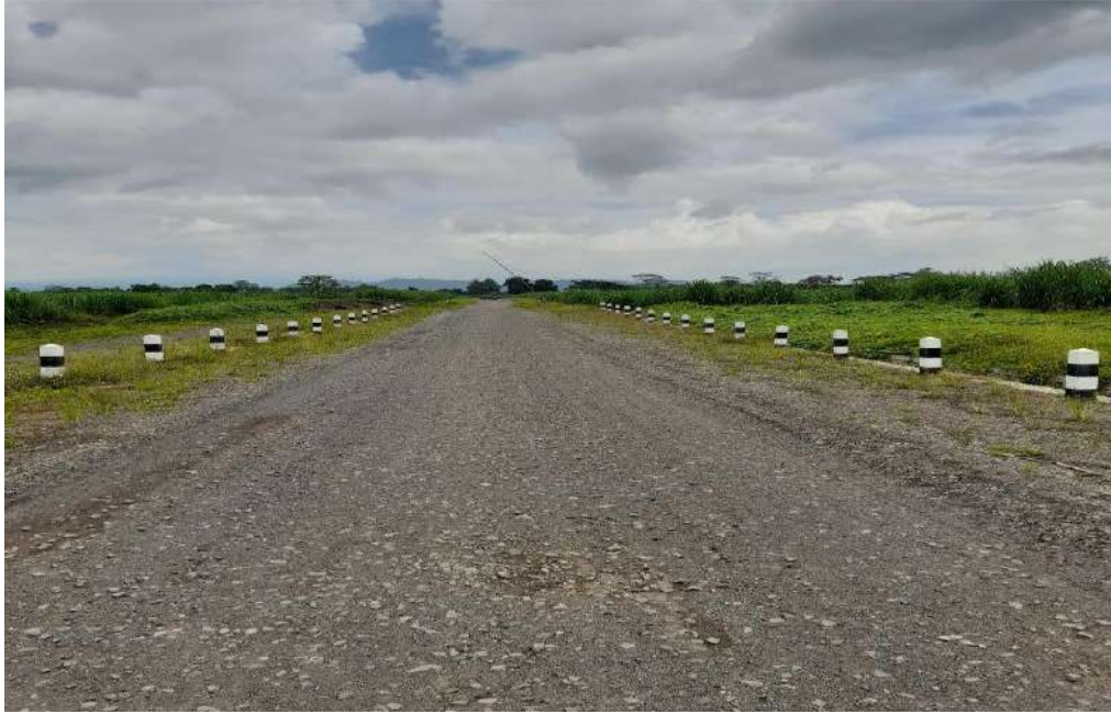
Gambar 21. Material Timbunan Jalan Yang Standar Tanah dan Batu, Lokasi Kebun Kalirejo
